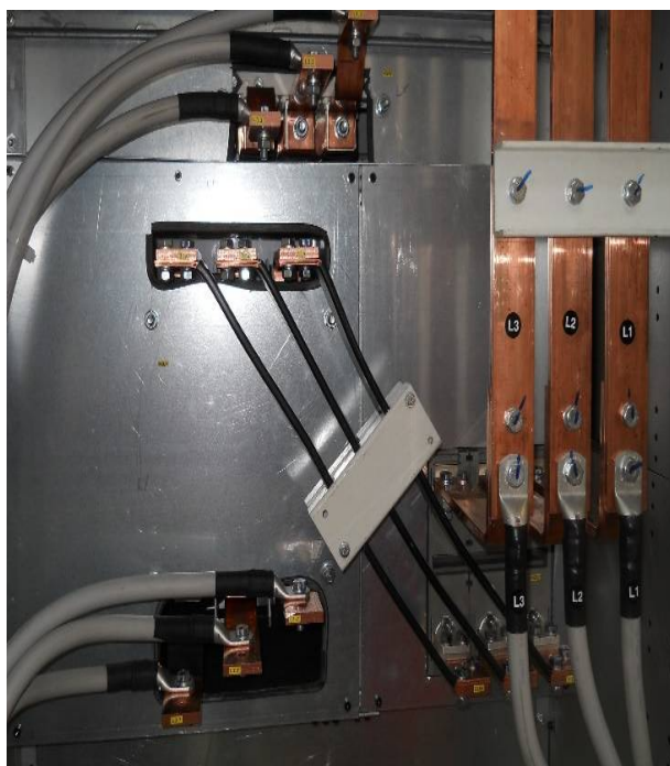
Центр управления двигателями (MCC) и щит управления
