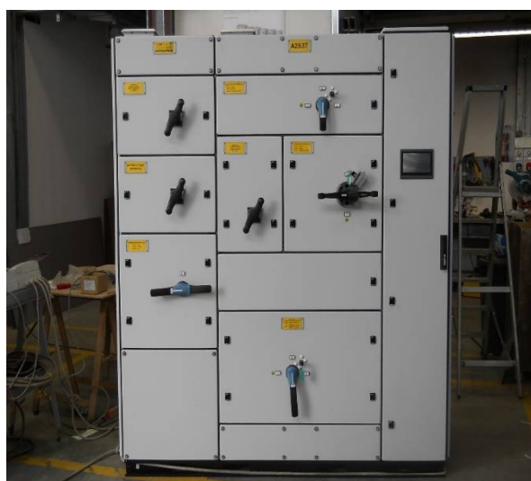
Центр управления двигателями (MCC) и щит управления
